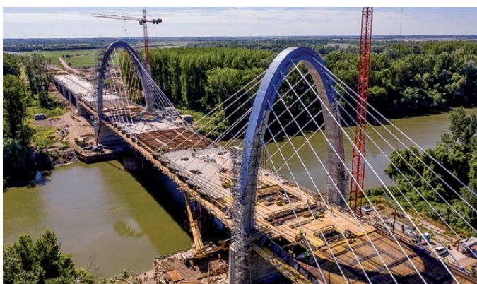
Az új híd építésénél 5800 méternyi vasbeton cölöp épült
